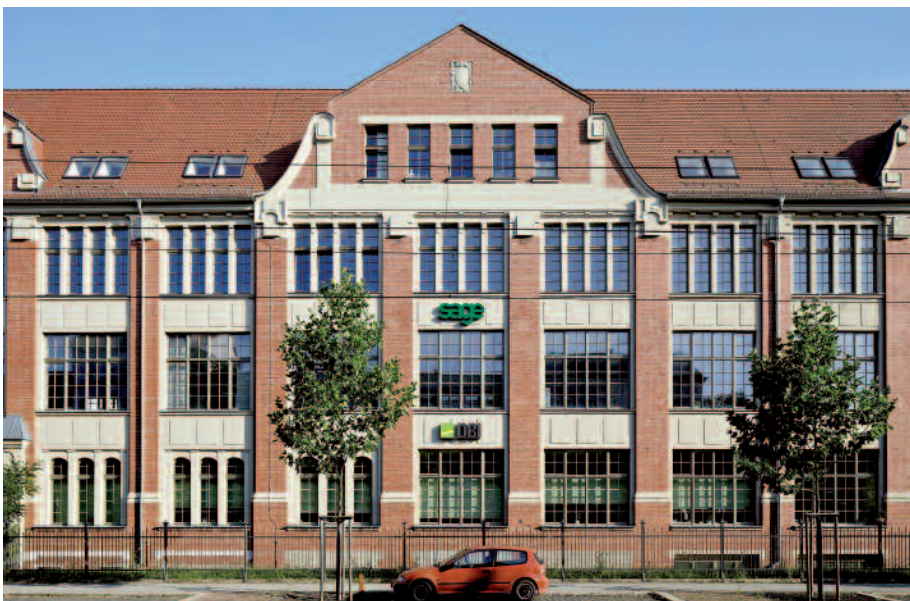
Ehemaliges Betriebsgebäude der Gebr. Brehmer, Leipzig
